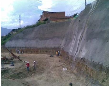
Foto 15. Cubrimiento de taludes
