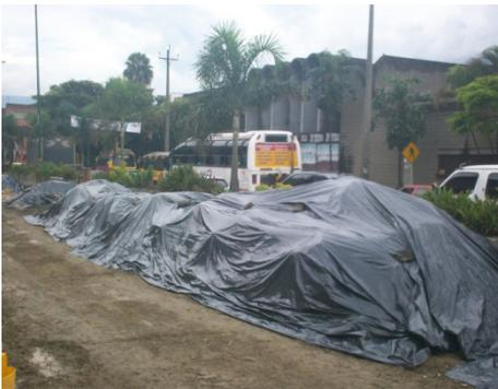
**Foto 4. Protección de escombros y excedentes de excavación**
