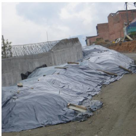
Foto 6. Protección de materiales susceptibles de generar material particulado
