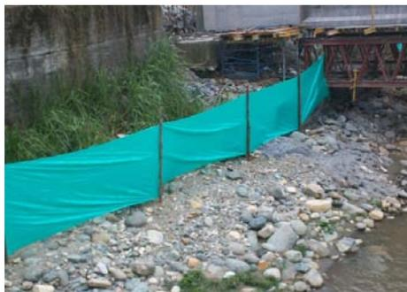
**Foto 21. Protección de fuentes de agua por caída de materiales**
