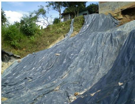
Foto 11. Protección de taludes
