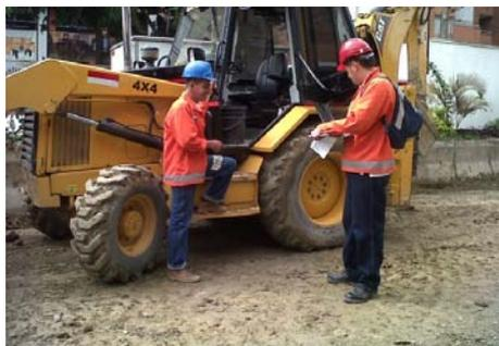
**Foto18. Inspección del estado de la maquinaria en obra**
