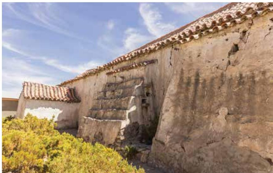
Contrafuertes escalonados y en talud, Isluga.
