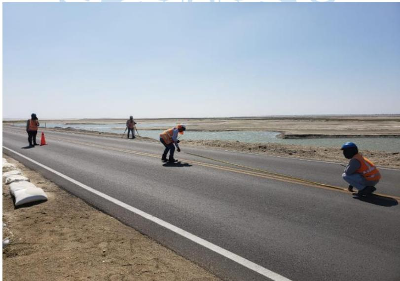
**Figura 44. Demarcación en la carretera de puntos a evaluar en la nivelación topográfica.**
