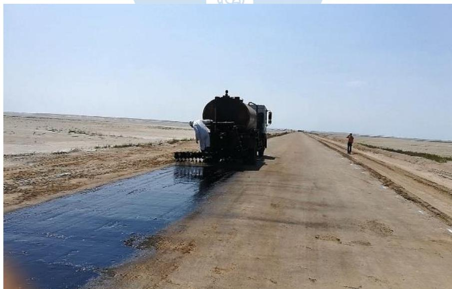
**Figura 26. Imprimación de emulsión asfáltica encima de la capa de afirmado.**
