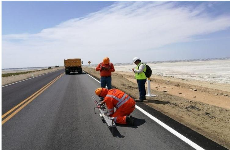
**Figura 33. Avance lento del camión para la toma de medida en el ensayo de viga Benkelman en campo.**
