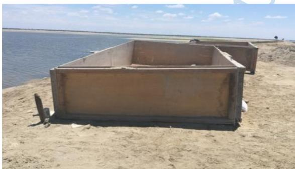
**Figura 20a. Encofrado de geobolsas en molde de madera.**
