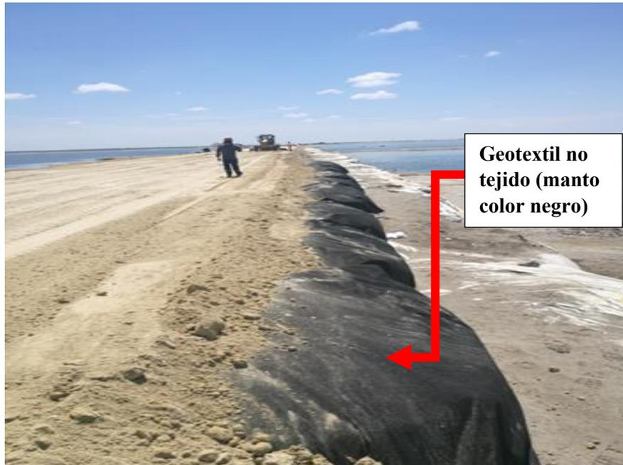
**Figura 24. Colocación del geotextil no tejido**
