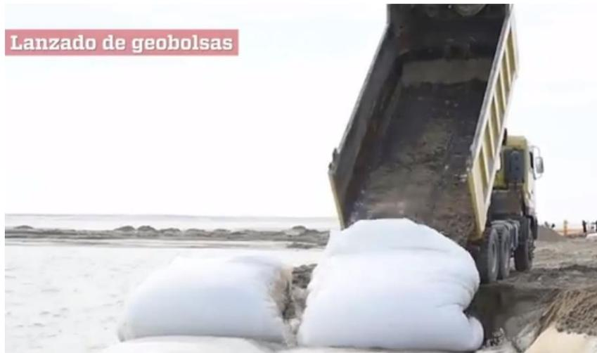
**Figura 18. Colocación de las geobolsas lanzadas con tolva del volquete para superar el nivel del agua.**
