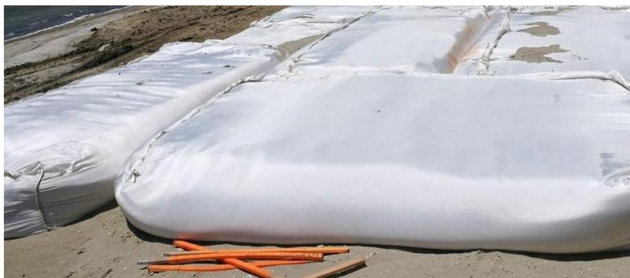
**Figura 23. Geobolsas encofradas in situ utilizadas para formar las bases de la vía en los tramos 2 y 4.**
