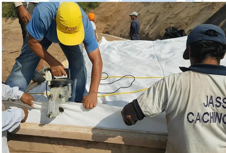
**Figura 22. Cierre de la tapa de la geobolsa en el encofrado in situ con cosedora portátil.**
