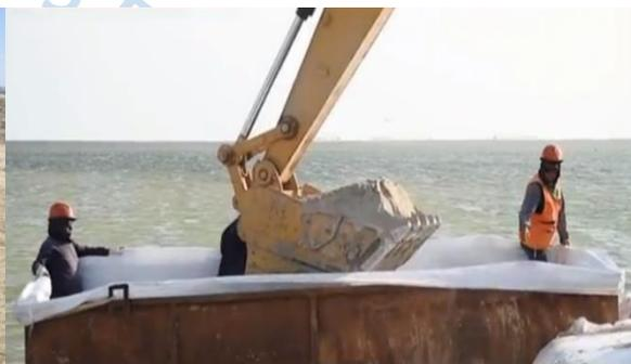
**Figura 20b. Encofrado de geobolsas en molde metálico.**
