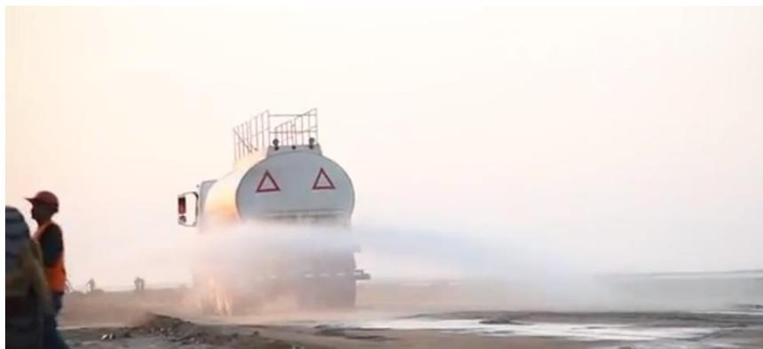
**Figura 25. Cisterna 4543.8 gal dando el óptimo grado de humedad a la capa de afirmado.**
